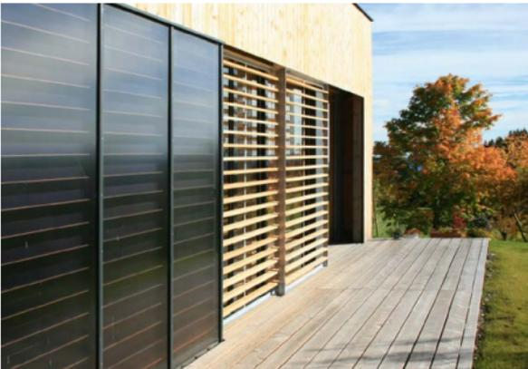
Gestalterisch überzeugende Integration einer Solarthermieanlage in die Fassade
