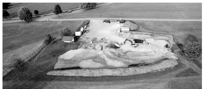
Da kaum Überdeckung vorhanden war, wurde dort erheblich mehr Ton bzw. Lehm wie geplant eingebaut. Aufgrund mehrerer Quellaustritte wurden insgesamt vier Schächte für zwei Quellaustritte mit Rollkies bzw. Filterkies errichtet, um die Schächte PE-Platten gesetzt und die Schächte mit Rohren verbunden.
